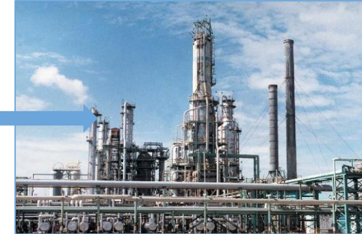
Biorrefinería a escala industrial
